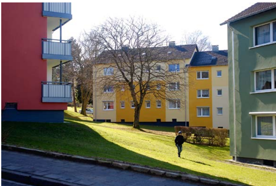
Neben Wärmedämmung und innovativem Heizsystem hilft das neue Energiesparportal in der Siedlung Pommernweg/Thüringer Straße Nebenkosten sparen.
