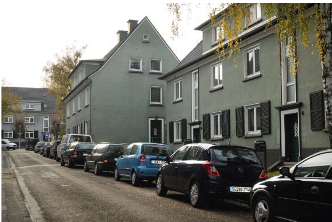
Die Großmodernisierung der Traditionssiedlung Weegerhof – hier Friedrich-Engels-Weg – nähert sich ihrem Abschluss.
