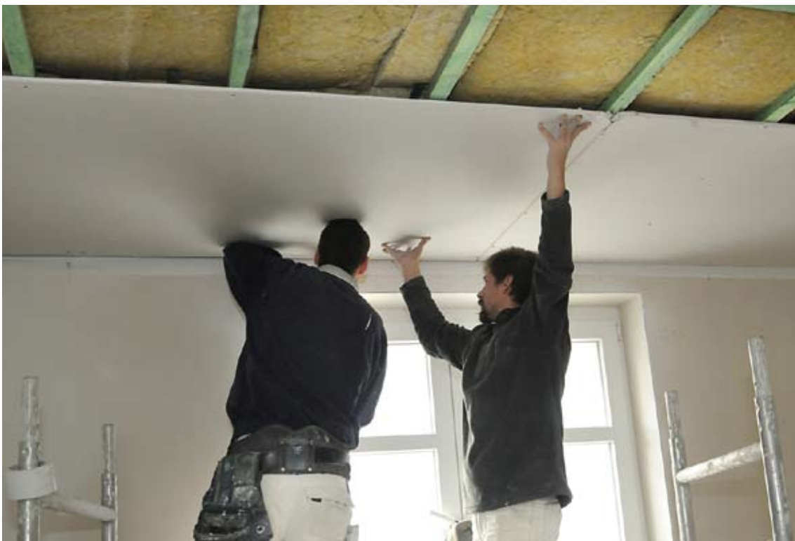
Die Investitionen des SBV in Modernisierung, Instandhaltung und Neubau sichern Arbeitsplätze in unserer Stadt.
